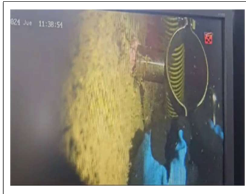
Muntatge tub DN80
