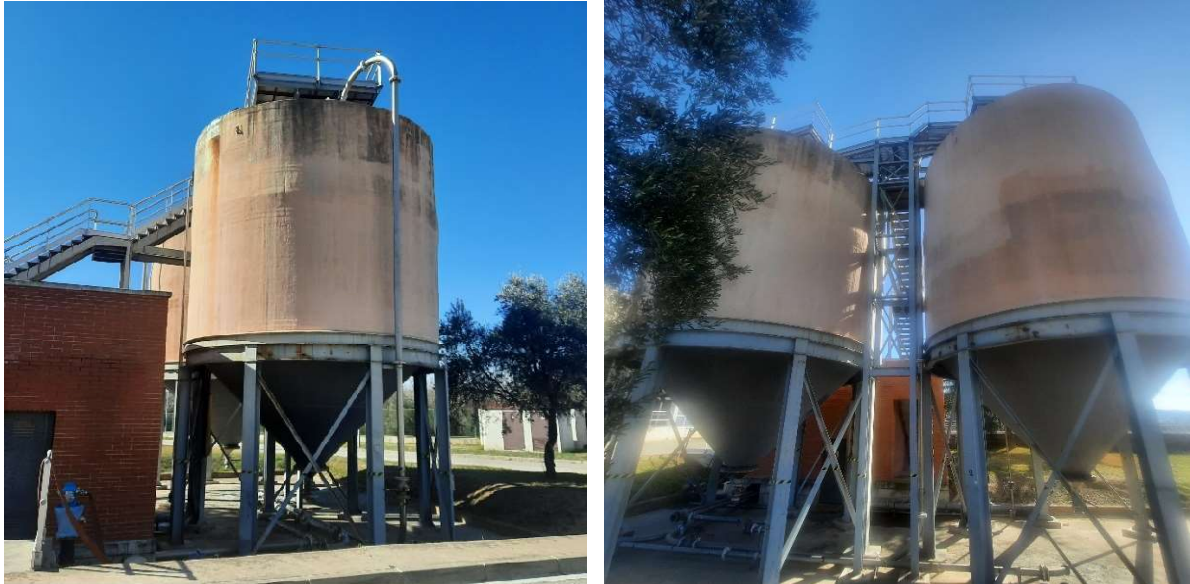
Vistes del les Sitges existents
