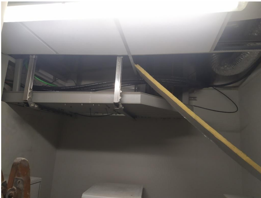
Fotografia 1.3: entrada dels tubs de mostres del costat SO en el magatzem de la planta soterrani
