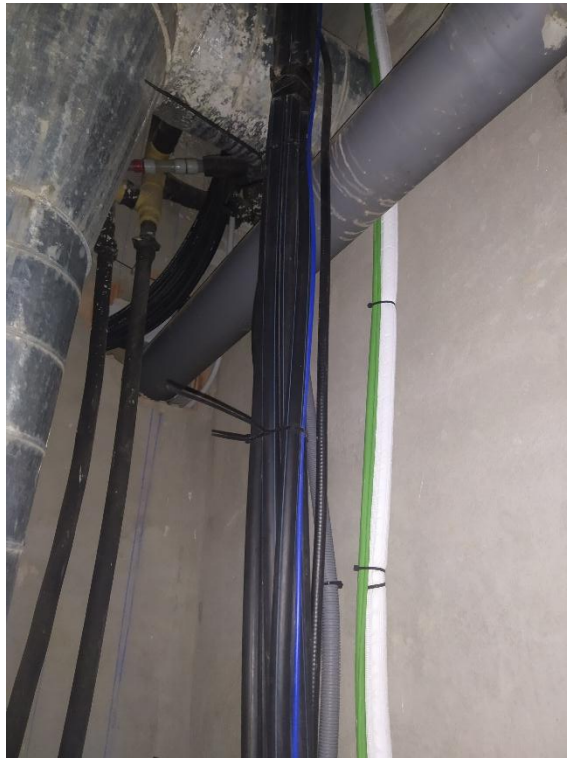
Fotografia 1.5: conjunt de tubs de mostres al pati d'instal·lacions de la planta baixa
