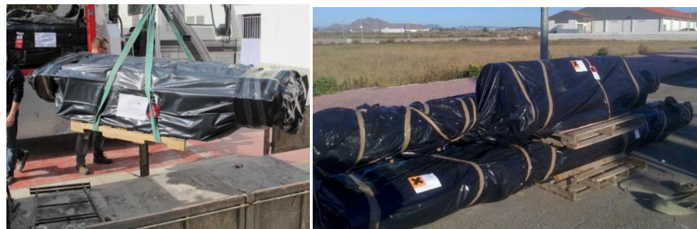
Exemple d'emmagatzematge temporal de tubs de fibrociment
